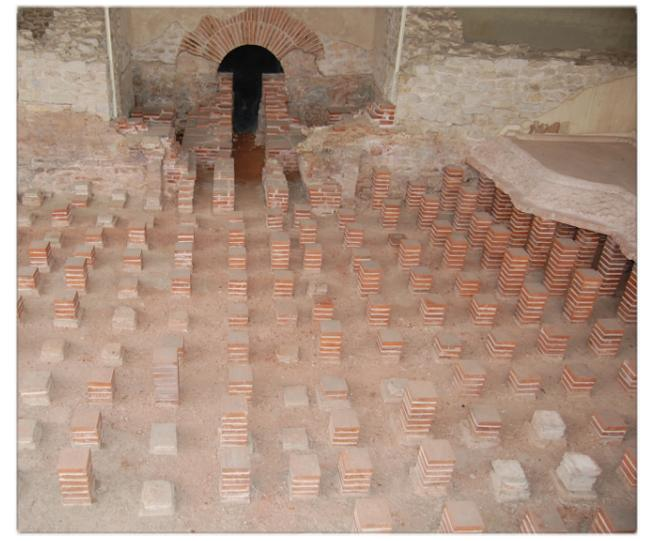
*Hypokaustanlage mit Heizkanal in der römischen Therme von Weißenburg: Von der Feuerstelle wurde die heiße Luft durch solche Kanäle unter die Fußböden der zu beheizenden Räume geleitet. Eine noch bessere und gleichmäßigere Hitze als Brennholz gewährleistete die Verbrennung von Holzkohle. Reste davon fanden sich auch in der Weißenburger Therme.*
